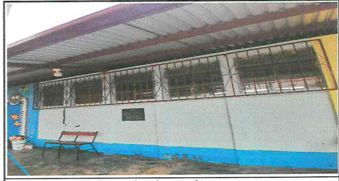
Foto 6: Pintura de balcones de aulas y cocina.
