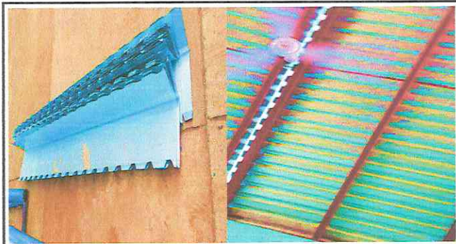
Foto 4: Sustitución de los capotes de lamina.
