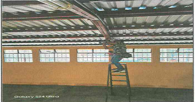
Foto 2: Reparación del ducto eléctrico más accesorios.
