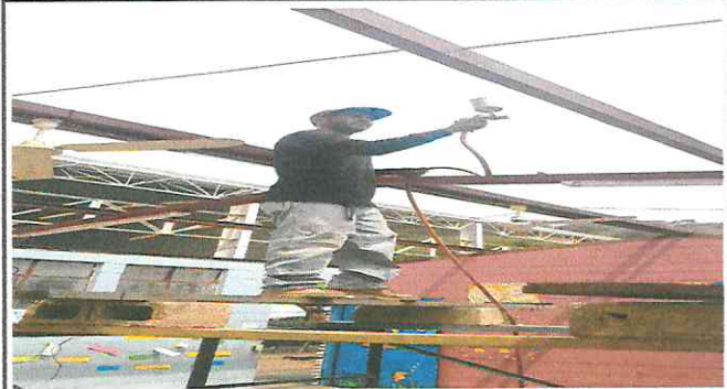
Foto 2: Mantenimiento de estructura de soporte
