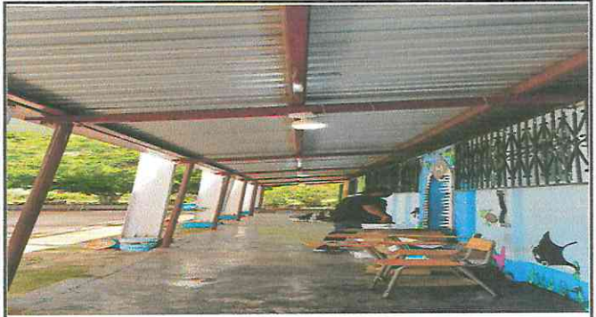
Foto 4: Reparación del ducto eléctrico más accesorios.
