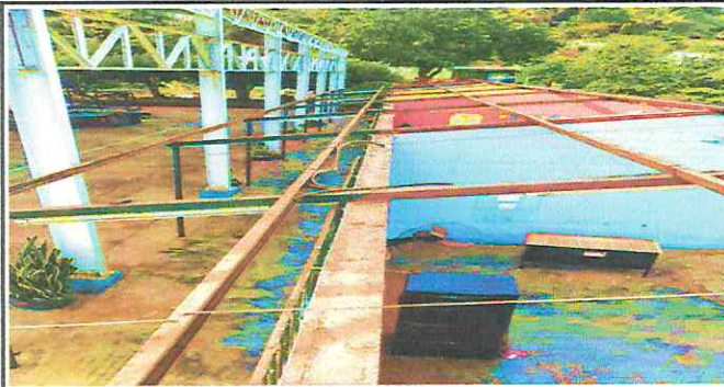
Foto1: Retiro de la lamina de zinc de aulas y cocina.
