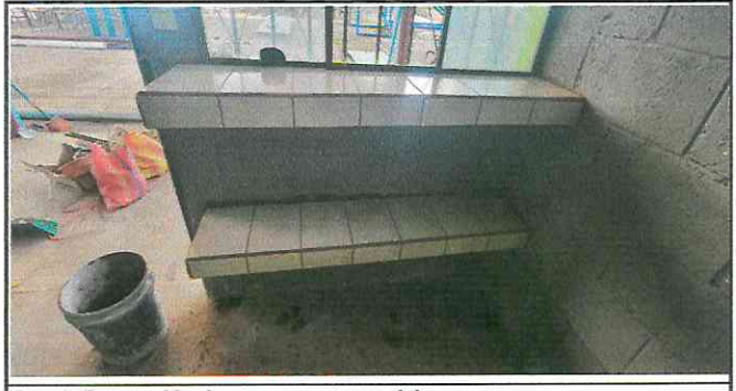
Foto 6: Reparación de mesones con azulejo
