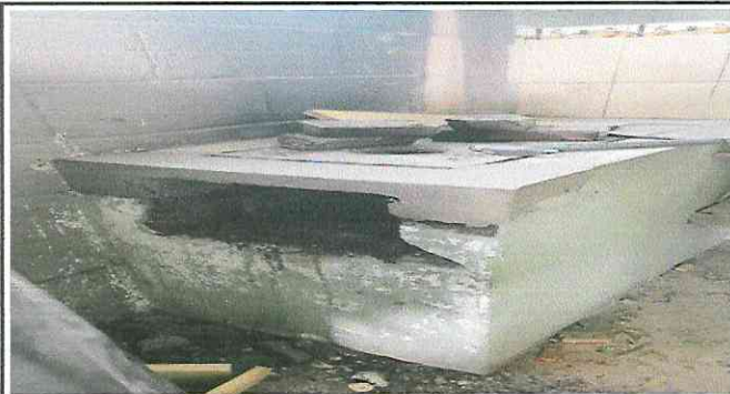
Foto 1: Reparación de estufa rural con sus accesorios
