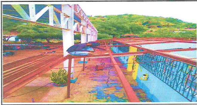
Foto 5: Sustitución de estructura de soporte de metal.
