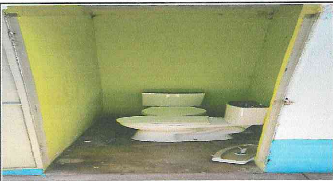
Foto 3: Sustitución de sanitarios con sus accesorios.
