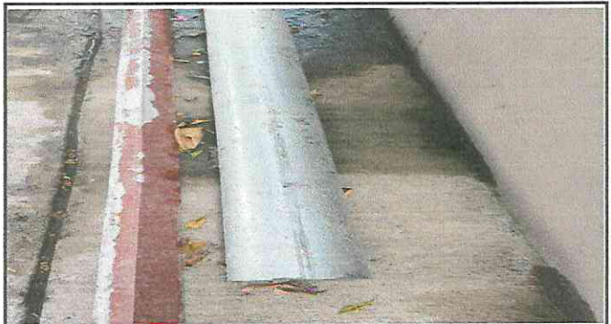
Foto 4: Sustitución de chimenea de metal
