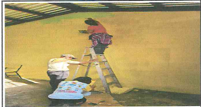
Foto 4: Pintura de aulas, cocina y sanitarios en interiores y exteriores
