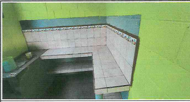
Foto 5: Reparación de estufa rural con sus accesorios
