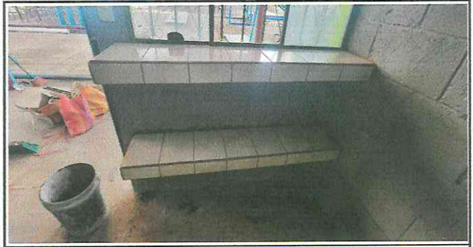
Foto 6: Reparación de mesones con azulejo
