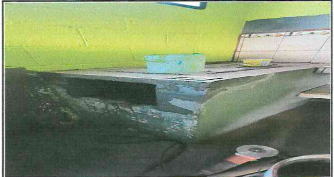
Foto 2: Reparación de estufa rural con sus accesorios
