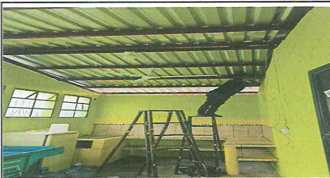
Foto 3: Reparación del ducto eléctrico más accesorios.
