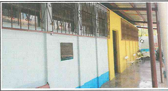
Foto 5: Pintura de aulas, cocina y sanitarios en interiores y exteriores
