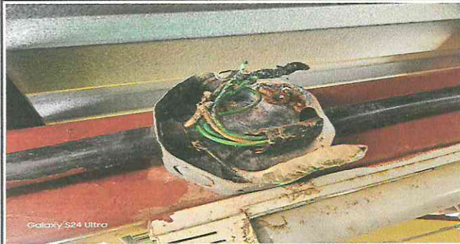
Foto 1: Reparación del ducto eléctrico más accesorios.
