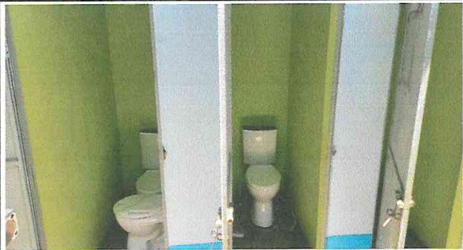
Foto 1: Sustitución de sanitarios con sus accesorios.
